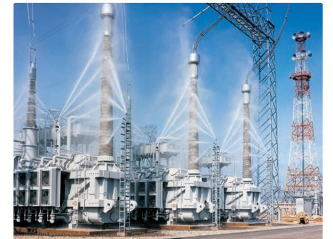
绝缘子带电清洗装置
